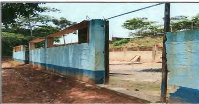
Foto 5: MODULO I: CAMBIO DE TECHO POR LAMINA TROQUELADA CALIBRE 26
