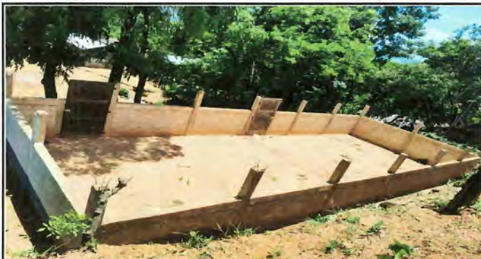
Foto1: MODULO I. LEVANTADO DE PARED DE DOS AULAS
