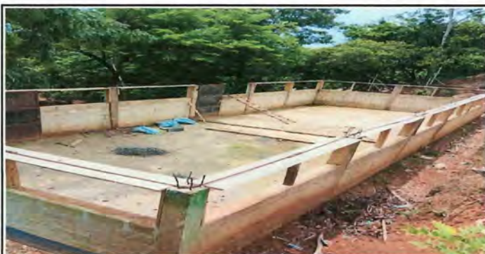
Foto 6: MODULO I: CAMBIO DE PISO DE TIERRA POR TORTA DE CEMENTO ALREDEDOR DE LAS AULAS 75CM
