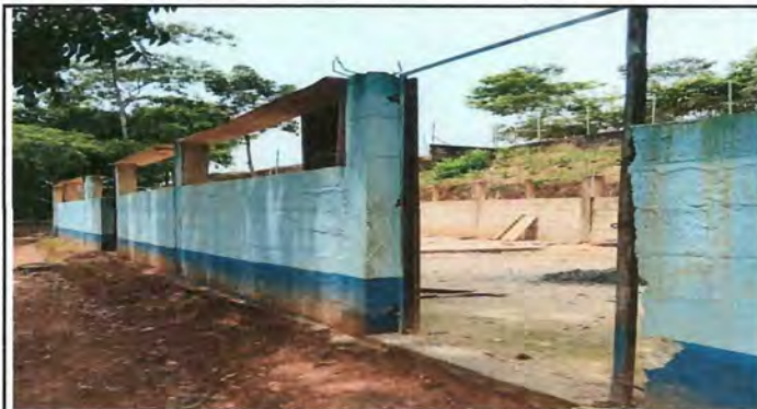
Foto 2: MODULO I: CAMBIO DE ESTRUCTURA DE MADERA POR ESTRUCTURA METALICA
