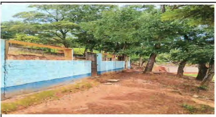
Foto 4: MODULO I: CAMBIO DE TECHO POR LAMINA TROQUELADA CALIBRE 26
