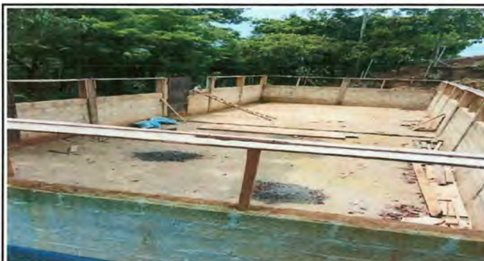
Foto 3: MODULO I: CAMBIO DE ESTRUCTURA DE MADERA POR ESTRUCTURA METALICA
